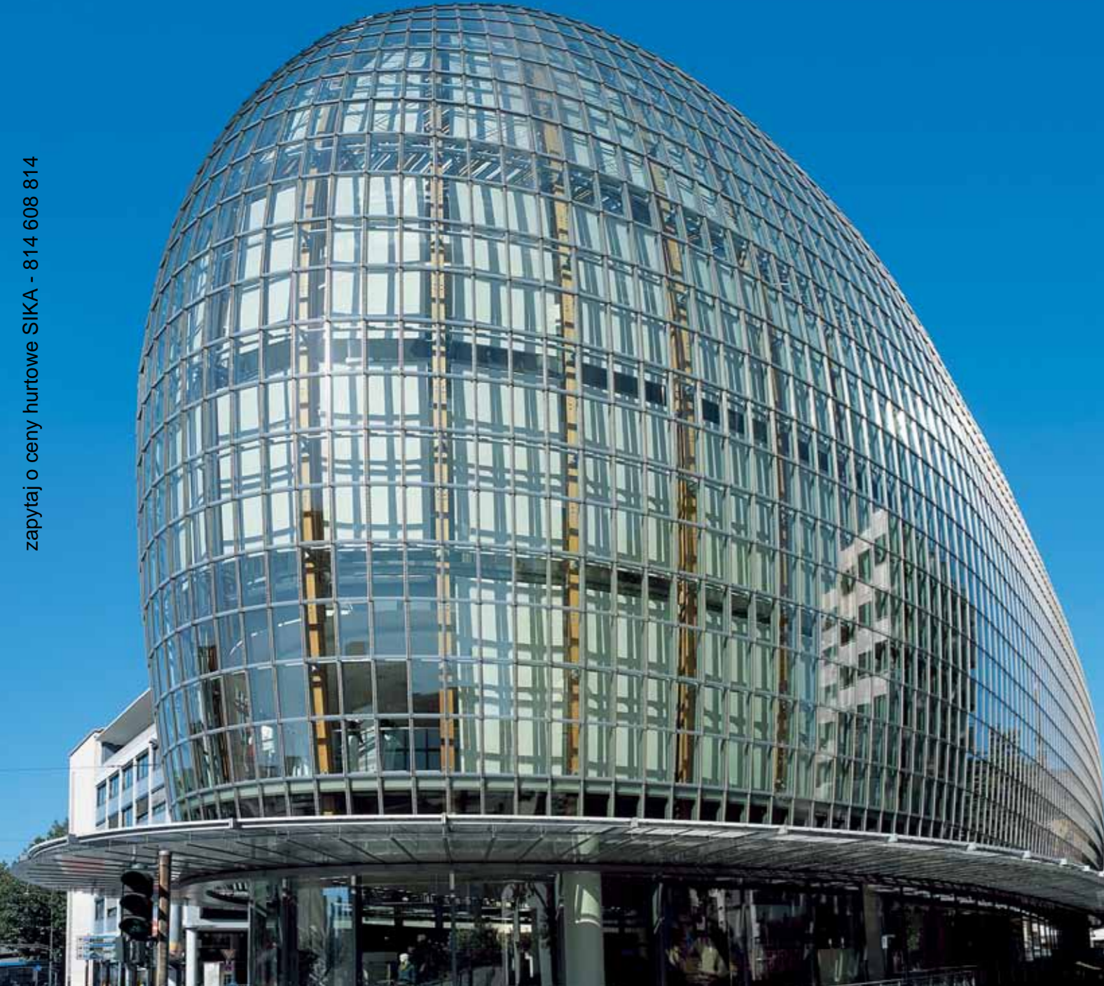
Przykład szklenia konstrukcyjnego i ochrony przed warunkami atmosferycznymi szklaną elewacją – sklep Peek&Cloppenburg, Kolonia, Niemcy
