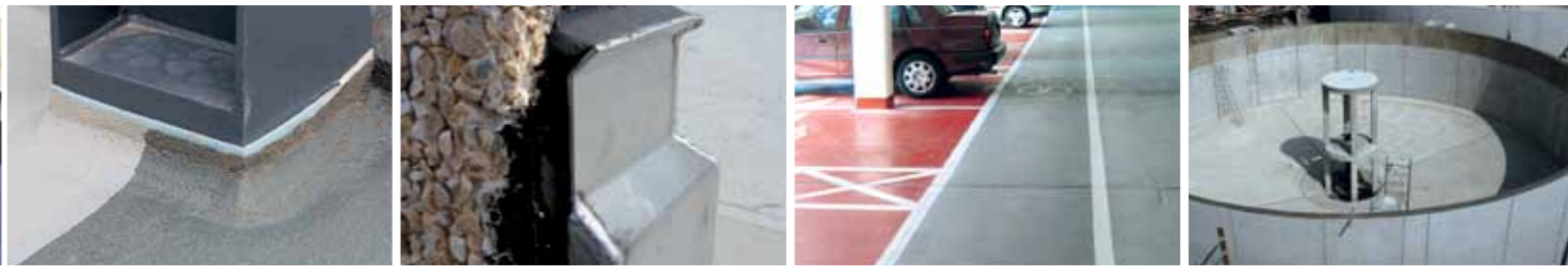
Szczeliny i detale w posadzce
