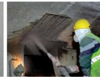
Naprawa, ochrona i wzmacnianie konstrukcji z betonu
