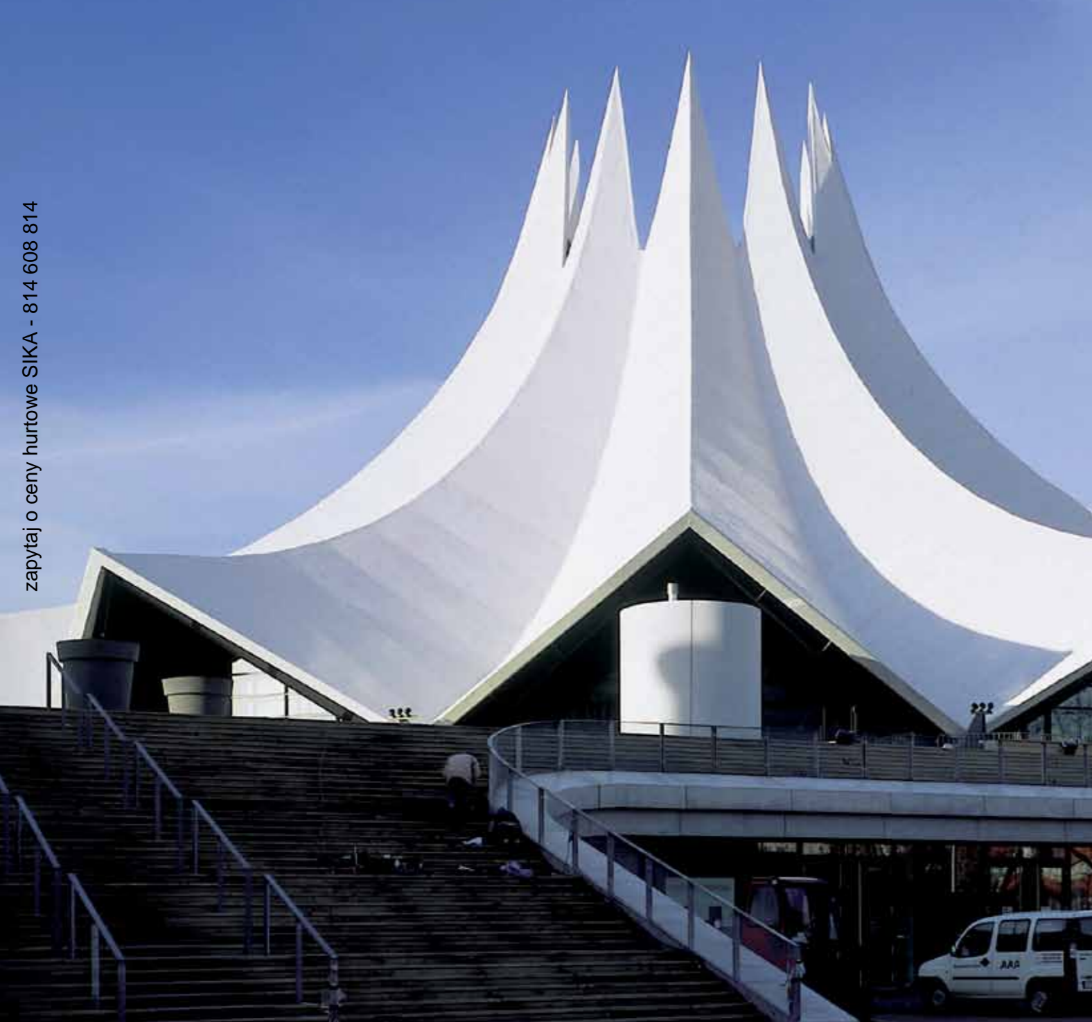
Krzywoliniowy dach pokryty mechanicznie mocowaną membraną Sarnafil® Tempodrom, Berlin, Niemcy
