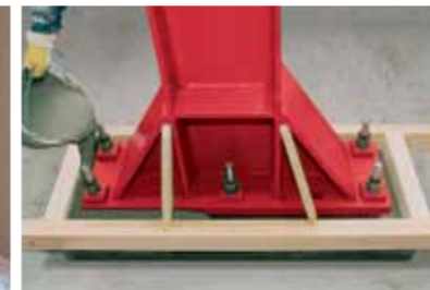
Podlewka z zaprawy cementowej
