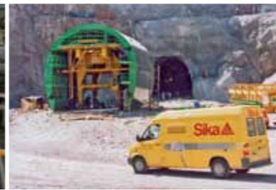
Dostawa na budowę
