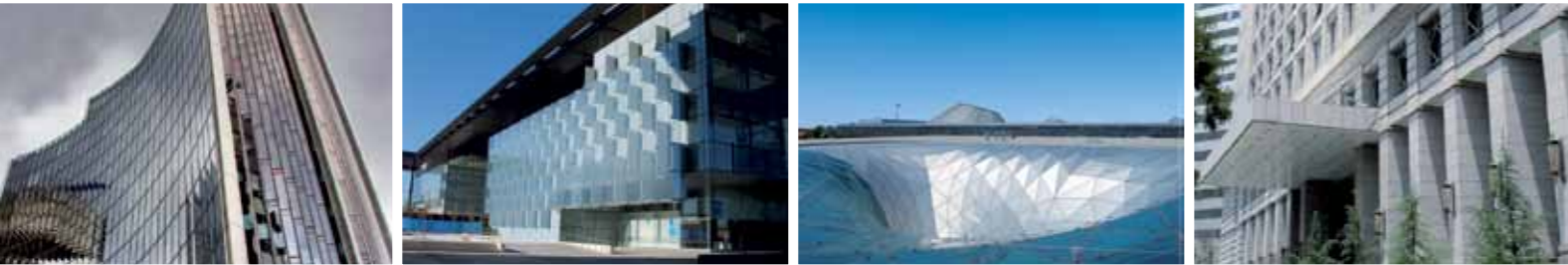
Szklenie konstrukcyjne Szklenie izolacyjne Ochrona przed warunkami atmosferycznymi okładziną metalowo-szklaną Zabezpieczenie przed warunkami atmosferycznymi okładziną z kamienia naturalnego
