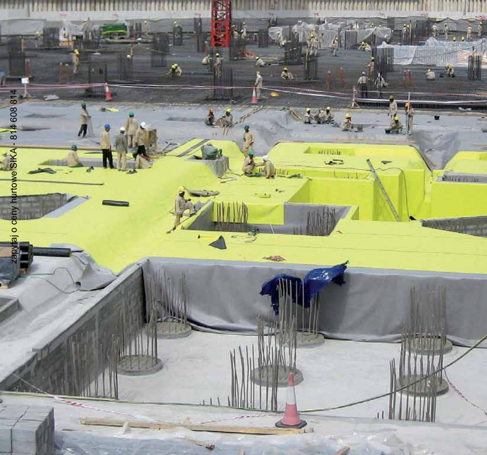
Uszczelnianie piwnic przy zastosowaniu membrany, Golden Mile, Dubai, UAE
