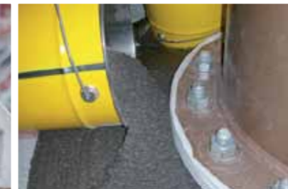
Podlewka z zaprawy epoksydowej
