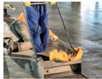
Posadzki, powłoki i klejenie elastyczne posadzek
