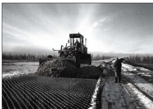
Rys. 8. Zасыpywanie kruszywem komórek geosiatki za pomocą ładowarki
