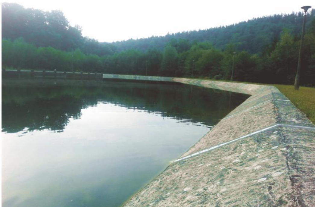
Stacja uzdatniania wody, Głuchołazy
