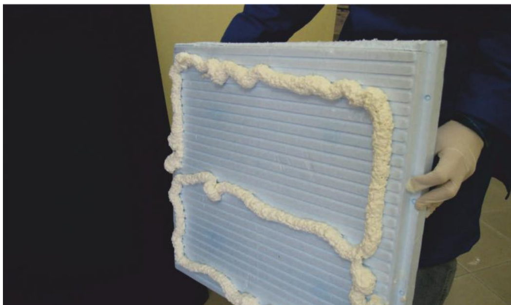
KLEJENIE PŁYT XPS NA PIANKĘ POLIURETANOWĄ
