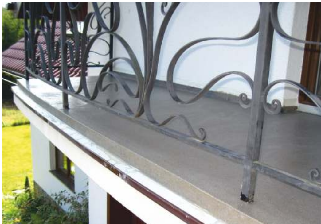
Balkon - posadzka epoksydowa, Banino
