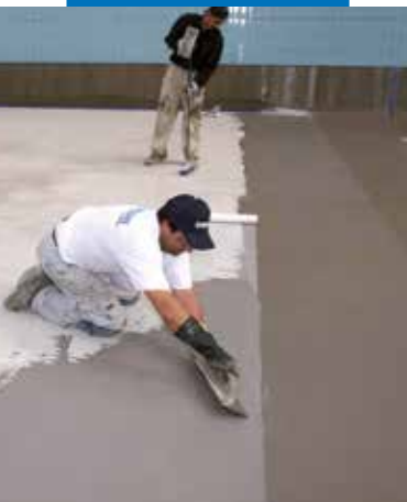
Hydroizolacja basenu z zastosowaniem Mapelastic
