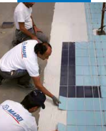
Montaż płytek ceramicznych na warstwie hydroizolacji Mapelastic
