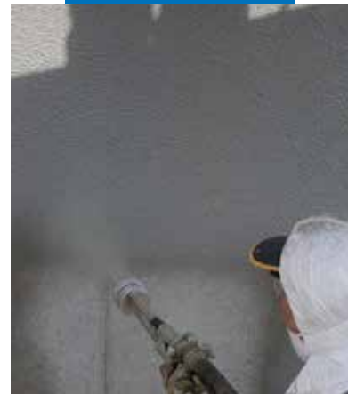
Nanoszenie Mapelastic metodą natryskową
