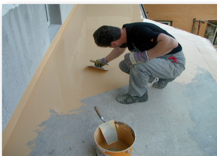
7. Pacą gładką aplikujemy materiał na podłoże
