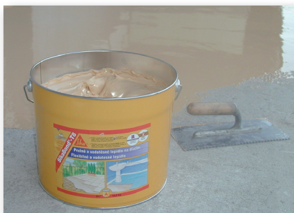
8. Warstwa izolacji: zużycie 1 kg/m 2 . Warstwa izolacji musi mieć jednolitą strukturę
