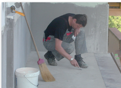
2. Następnie oczyszczamy podłoże z luźnych związków, a następnie odpylamy powierzchnię. Nie zalecamy gruntowania
