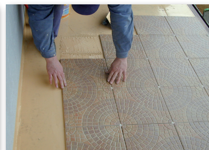
12. Fugi wykonujemy z elastycznego materiału poliuretanowego Sikaflex®-11 FC
