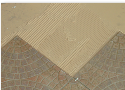
10. Zużycie materiału 1,5 kg/m 2 .
