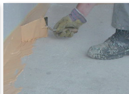
6. Izolujemy materiałem SikaBond®-T8 przejście pionu z poziomem
