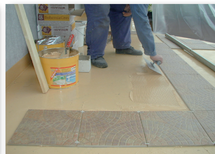
9. Po utwardzeniu materiału (min. 20 godzin) nakładamy warstwę klejącą pacą grzebieniową
