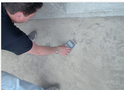
1. Przed aplikacją materiału SikaBond®-T8 konieczne jest suche i równe podłoże
