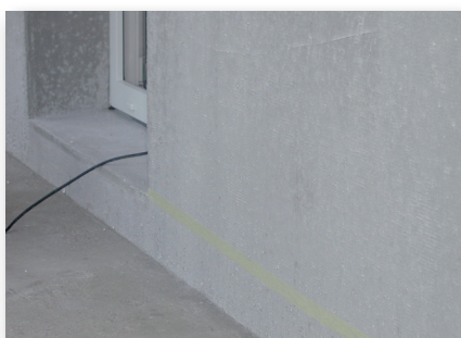
5. Aby zniwelować kąt pomiędzy pionem a poziomem aplikujemy Sikaflex®-11 FC
