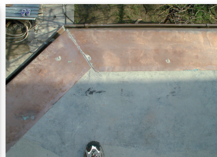
3. Obróbki blacharskie odłuszczone i gruntujemy materiałem Sika®-Primer 3
