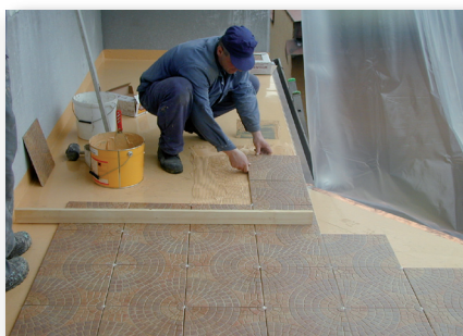
11. Klej aplikujemy tylko na podłoże
