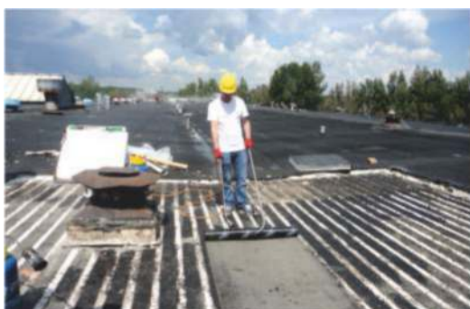
Zgrzewanie papy paroizolacyjnej na starym podłożu z blachy
