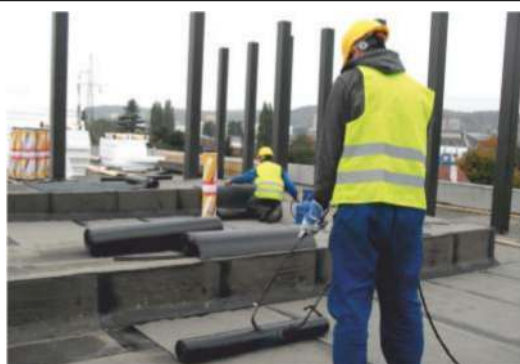
Druga warstwa papy zgrzewalnej, zgrzewanie drugiej części rolki
