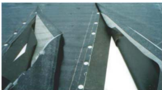
Zabezpieczenie papą tradycyjną płyt EPS pod zakładami papy
