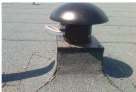
Obróbka elementu wentylacyjnego na dachu na dachu
