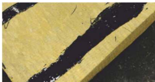
Pasy lepiku IZOHAN SBS-tixo położone na dolną stronę płyt z wełny mineralnej
