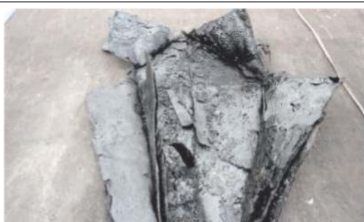
Suszenie podłoża pod pęcherzami z papy
