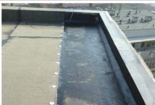
Papa podkładowa na wilgotnym, zagruntowanym podłożu
