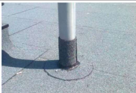
Obróbka elementu pionowego o okrągłym kształcie
