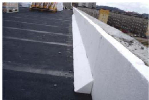
Styk powierzchni pionowej z poziomą
