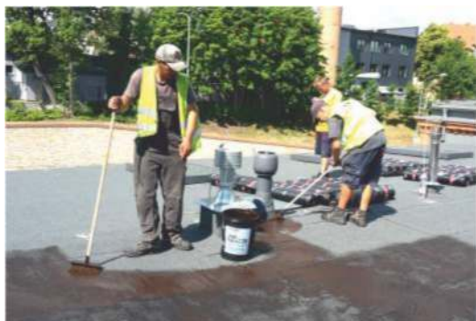
Gruntowanie podłoża - stare pokrycie papowe
