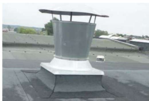
Obróbka elementu pionowego
