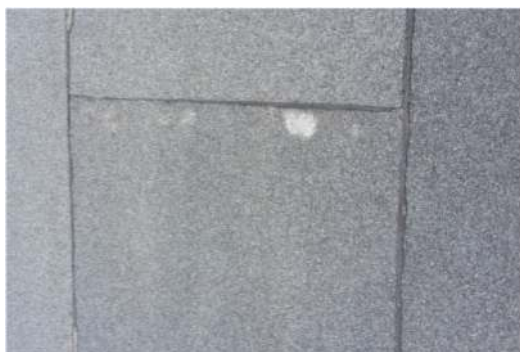
Prawidłowy wytop asfaltu na zakładzie podłużnym i poprzecznym
