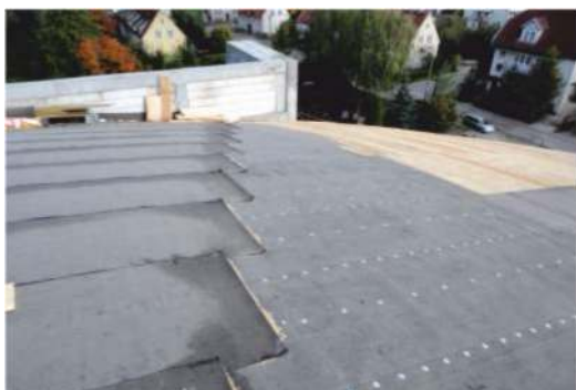
Pokrycie trójwarstwowe na deskach. Pierwsza i druga warstwa
