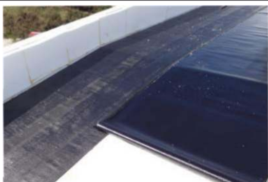
Zastosowanie papy samoprzylepnej
