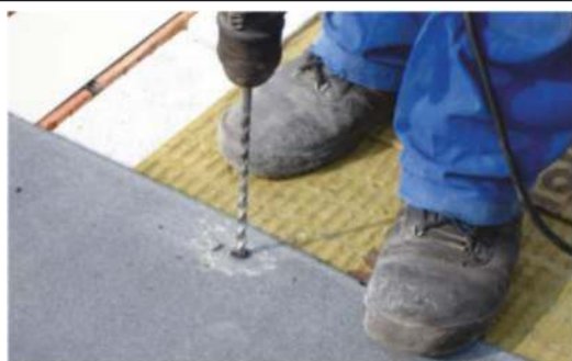
Mocowanie mechaniczne papy podkładowej na wełnie
