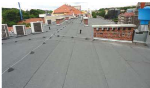
Wyremontowane pokrycie dachowe
