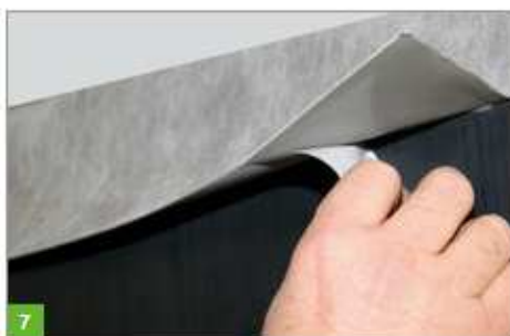
7 Wzmocnianie styków taśmą butylową BOTAMENT BD.
