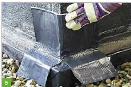
5 Klejenie narożników zewnętrznych
