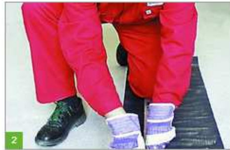
2 Przycięcie bitumicznej izolacji samoprzylepnej za pomocą noża.
