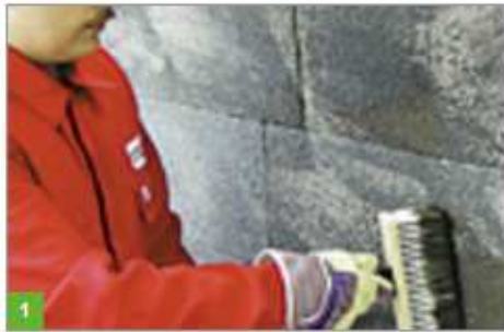
1 Gruntowanie podłoża za pomocą BOTAMENT BE 901 albo BOTAMENT B 97 L
