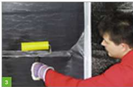
3 Docięnięcie za pomocą wałka gumowego. Klejenie narożników wewnętrznych.
