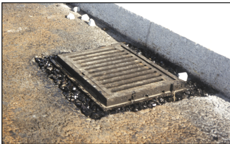
Rys. 30. Wpust mostowy przed ułożeniem warstwy ścieralnej. Wokół wpustu widoczny jest dren z lakierowanych grysów
