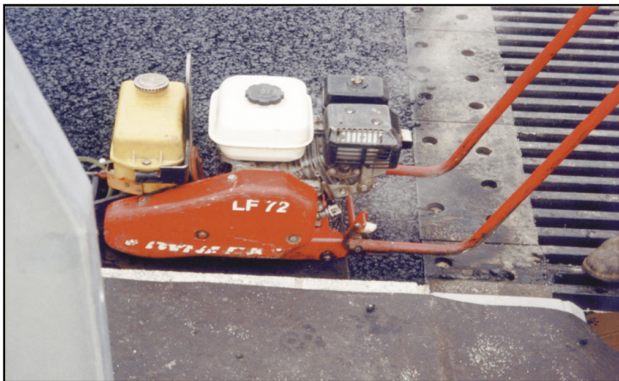
Rys. 29. Zagęszczanie warstwy ścieralnej nawierzchni przy urządzeniu dylatacyjnym za pomocą płyty wibracyjnej
