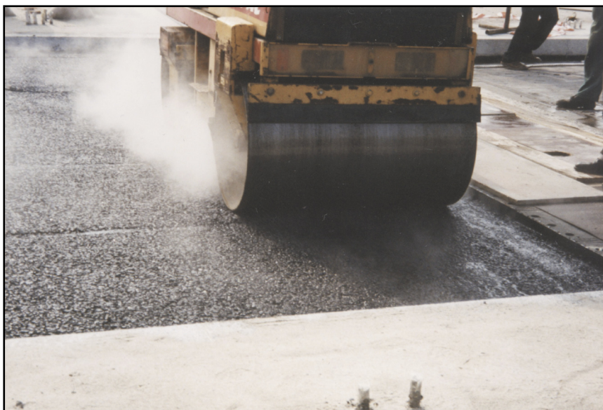
Rys. 28. Zagęszczanie warstwy wiążącej nawierzchni przy urządzeniu dylatacyjnym za pomocą małego walca poruszającego się równolegle do osi urządzenia dylatacyjnego
