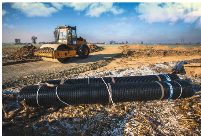
Droga dojazdowa do farmy wiatrowej. Inczew
