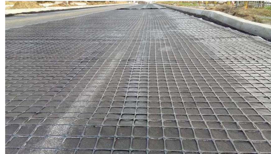
📍 Kalisz (woj. wielkopolskie) 📄 Przebudowa drogi i wzmocnienie warstwy bitumicznej 🔲 Polgrid FSR BX20/20 150PP 14.400 m 2
