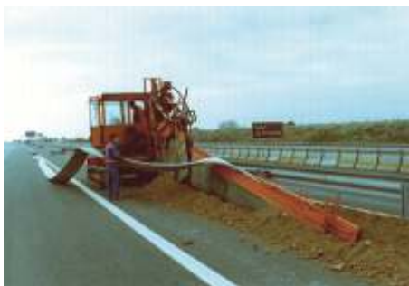
Rys. 33. Instalowanie kompozytu drenażowego jako odwodnienia podłużnego drogi.
