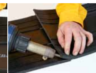
Złącze na zakład przy użyciu gorącego powietrza
