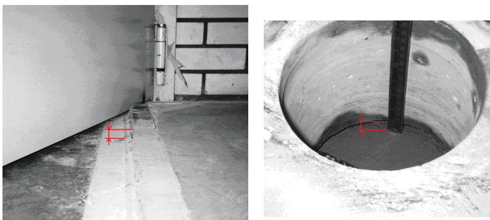
Rys. 55. Klinowanie się stalowych wrót na skutek podniesienia się naroża i odwiert rdzeniowy w narożu - widoczna szczelina w płaszczyźnie styku posadzki z betonowym podłożem, spowodowana podniesieniem się naroża
