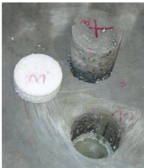
Rys. 64. Odwiert rdzeniowy; miękki styropian pod płytą posadzki
