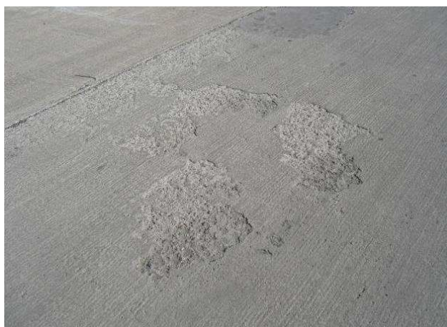
Rys. 39. Rozwarstwienie warstwy wierzchniej i podkładu
