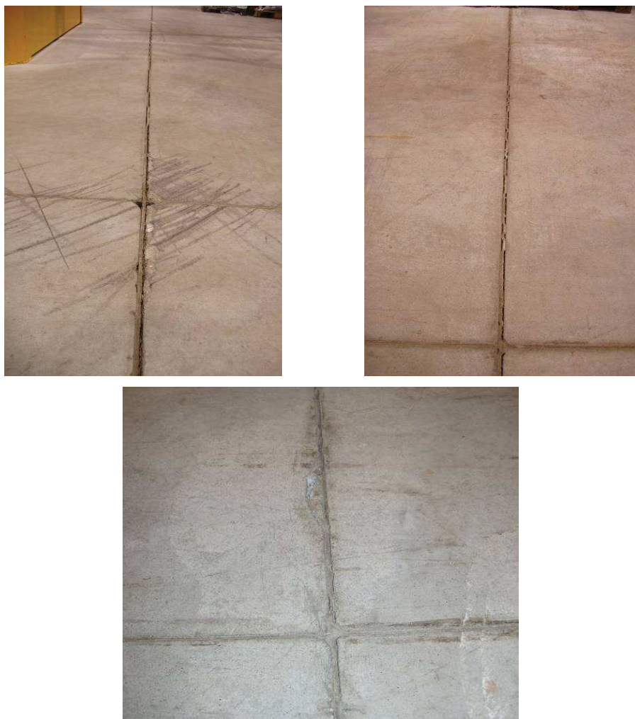
Rys. 63. Uszkodzenia dylatacji
