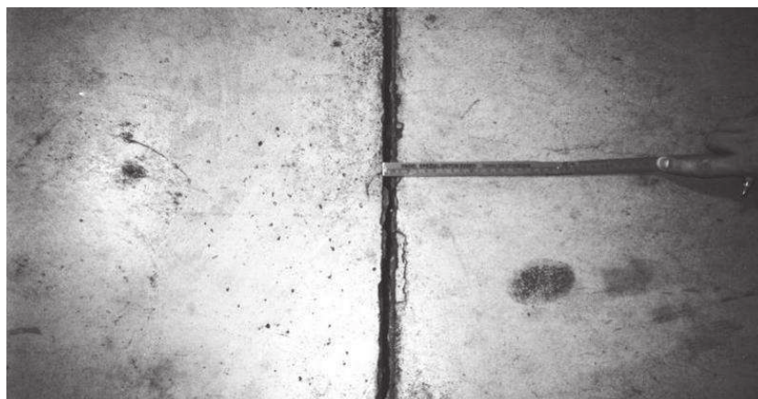
Rys. 59. Rozszerzenie się dylatacji, odspojenia mas elastycznych i wykruszenia krawędzi
