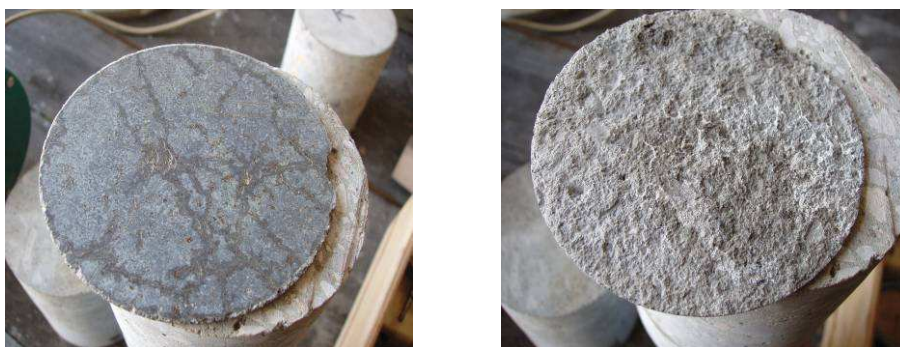
Rys. 56. Widok odspojonej górnej warstwy utwardzonej posadzki: z lewej - widok od góry, z prawej - widok dolnej powierzchni odspojonej warstwy
