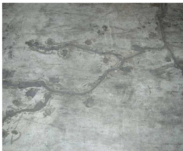
Rys. 41. Rysy naprawione metodą iniekcji
