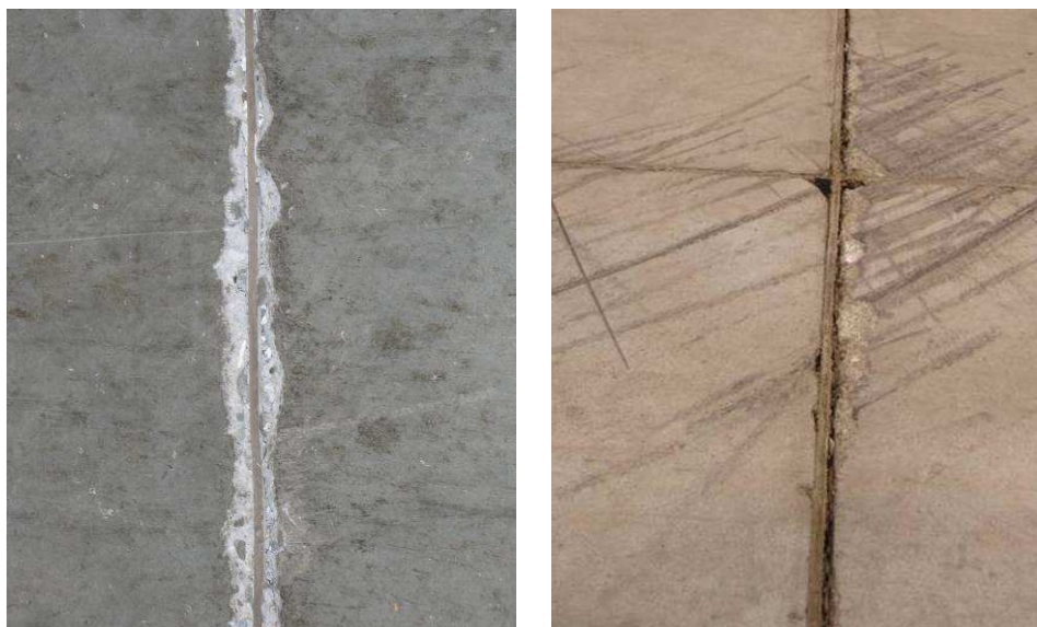
Rys. 33. Przykłady wyruszeń krawędzi dylatacji
