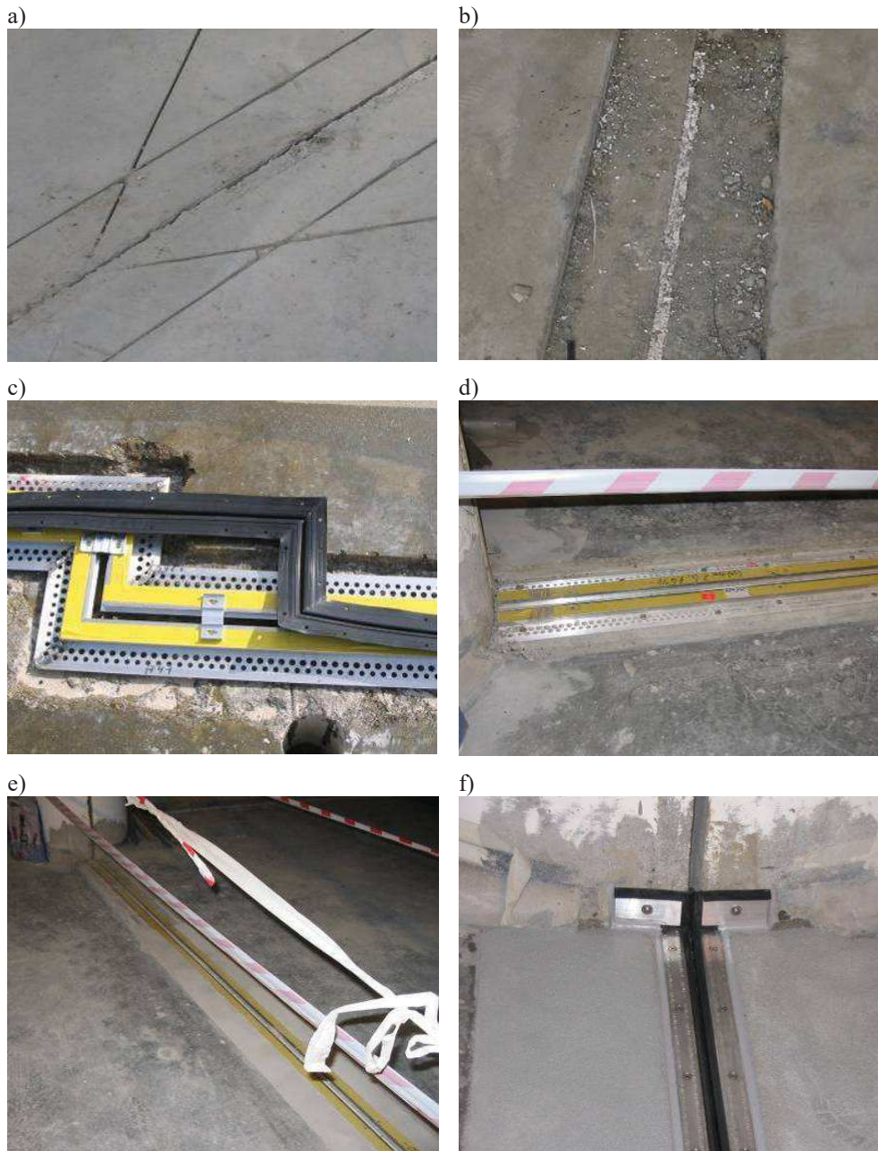
Rys. 51. Wykonanie naprawy dylatacji przez założenie profili dylatacyjnych [48]: a) nacięcie betonu, b) wykonanie bruzd, c) ułożenie profili w bruzdach, d) mocowanie profili, e) wypełnienie bruzdy, f) usunięcie folii ochronnej – zakończenie prac
