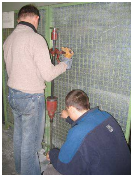
Rys. 15. Badanie podbudowy gruntowej z wykorzystaniem lekkiej sondy dynamicznej SL
