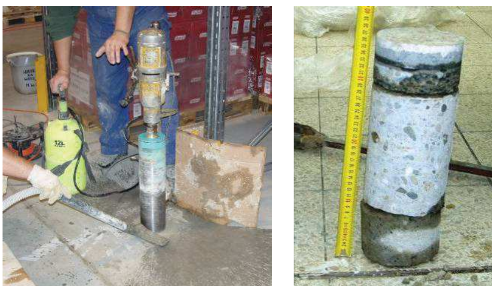
Rys. 11. Odwiert rdzeniowy i pomiar grubości podkładu
