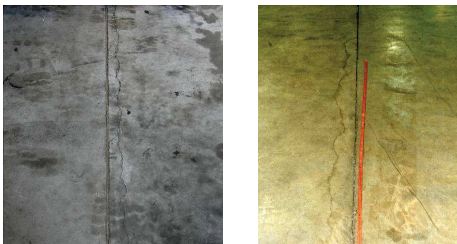
Rys. 28. Zarysowania wzdłuż krawędzi posadzki
