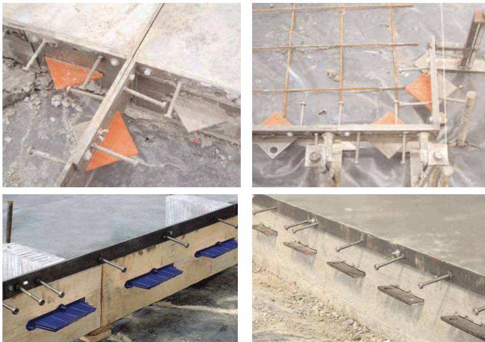
Rys. 48. Przykłady zastosowania szalunków traconych z zamocowanymi dyblami [47]
