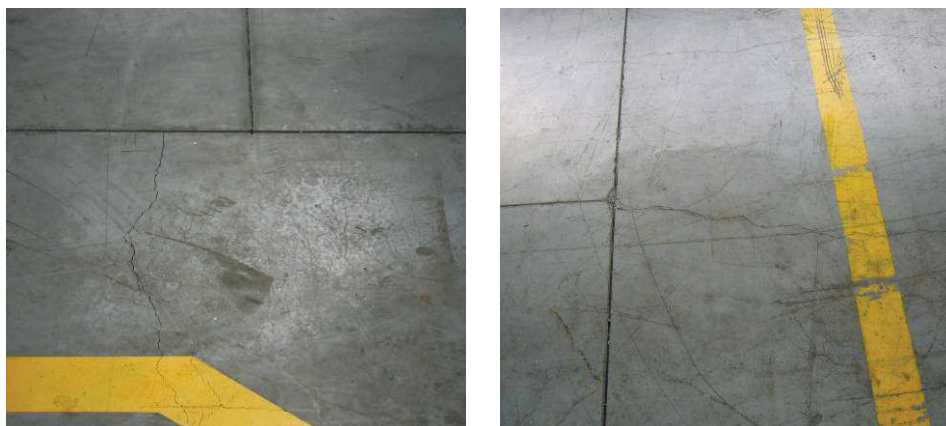
Rys. 22. Zarysowania na przedłużeniu nacinanej dylatacji
