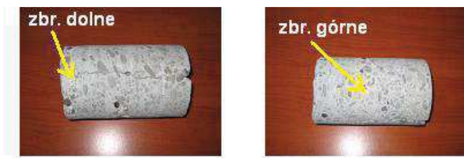
Rys. 13. Identyfikacja zbrojenia w wyciętej próbce rdzeniowej
