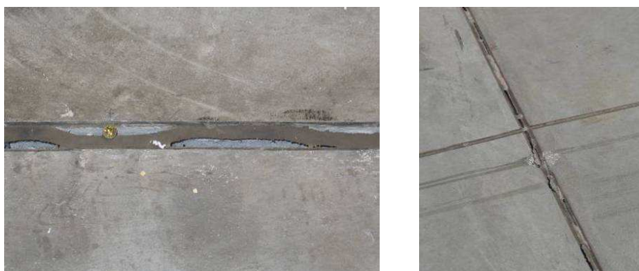
Rys. 38. Odspojenia kitów wypełniających dylatacje
