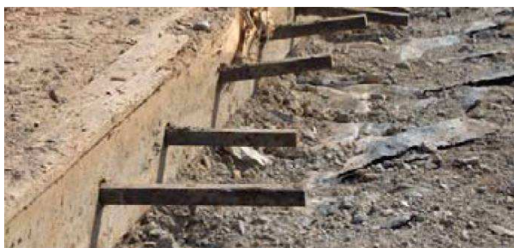
Rys. 37. Rozebrany fragmenty posadzki przy dylatacji – widoczne ukośne dyble [47]
