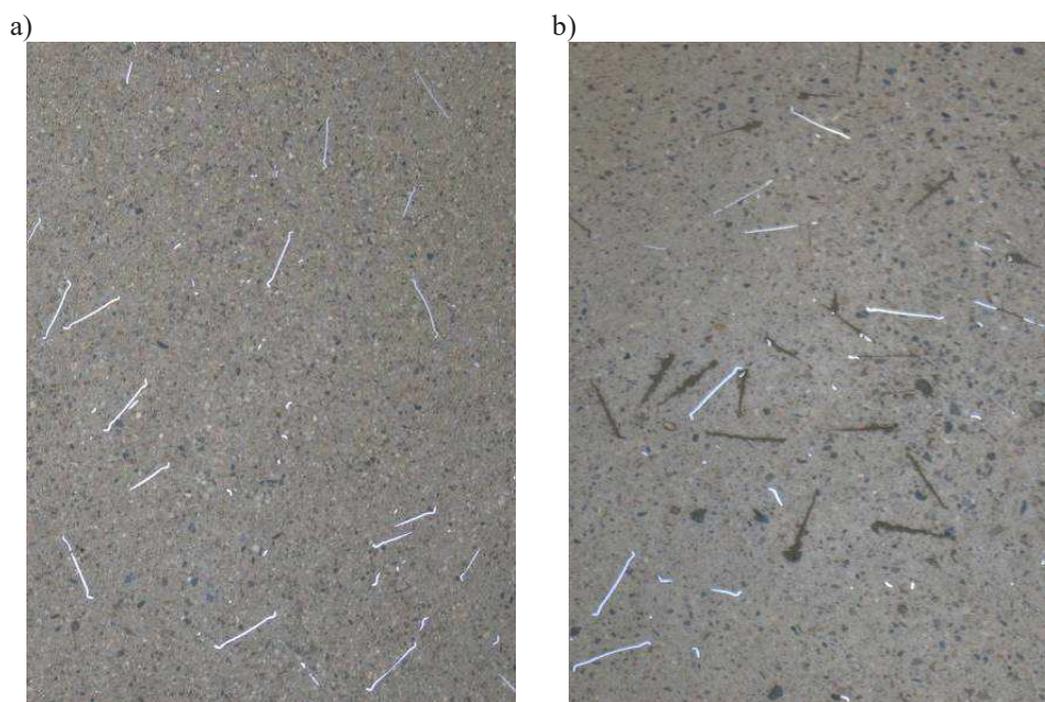
Rys. 31. Zbrojenie rozproszone na powierzchni posadzki: a) widoczne włókna stalowe w dużej ilości, b) bruzdy na powierzchni posadzki po wyrwaniu włókien zbrojenia
