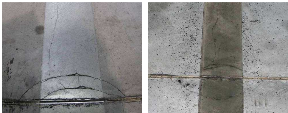
Rys. 35. Wyłamania krawędzi dylatacji przez źle osadzony kątownik pod działaniem obciążenia kołami środków transportowych
