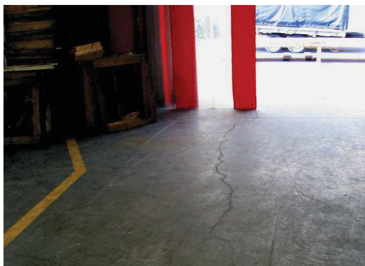
Rys. 18. Rysa w okolicy bramy wjazdowej
