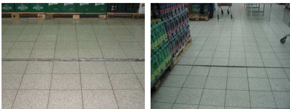
Rys. 39. Klawiszowanie dylatacji spowodowane wpływami eksploatacji górniczej
