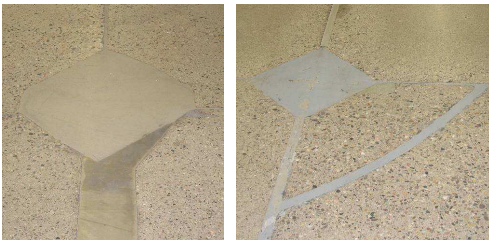
Rys. 44. Uzupelnienie uszkodzonych naroży nowym betonem
