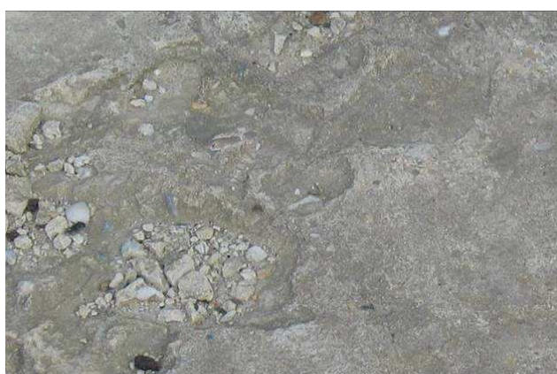
Rys. 30. Lejkowate odpryski typu „pop-out”
