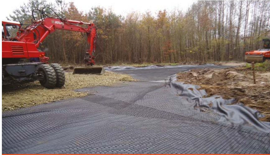
📍 Chojna (woj. zachodnio-pomorskie) 📄 Modernizacja dróg leśnych 🔲 Polgrid 30/30 oraz geotkanina separacyjna 30.000 m 2
