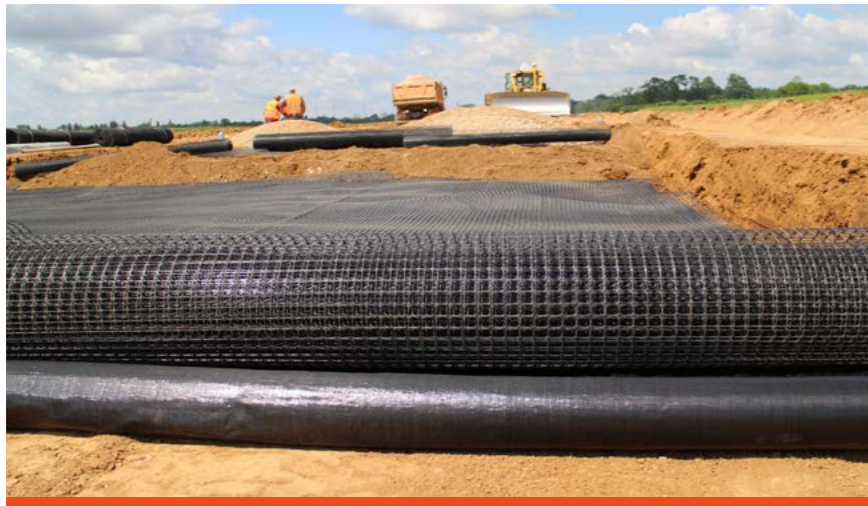
📍 Płock (woj. mazowieckie) 📄 Budowa trasy północno-zachodniej miasta Płock 🔲 PolGrid BX30/30 ilość 82 000m 2
