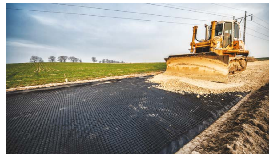
📍 Kępno (woj. wielkopolskie) 📄 Budowa drogi dojazdowej do farmy wiatrowej 🔲 Polgrid BX 30/30 60.000 m 2
