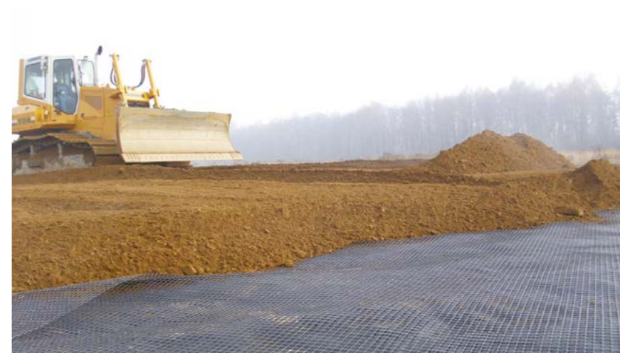
📍 Rzeszów (woj. podkarpackie) 📄 Zbrojenie nasypu przy budowie drogi S19 🔲 Polgrid BX 20/20 oraz geotkanina separacyjna 35.000 m 2
