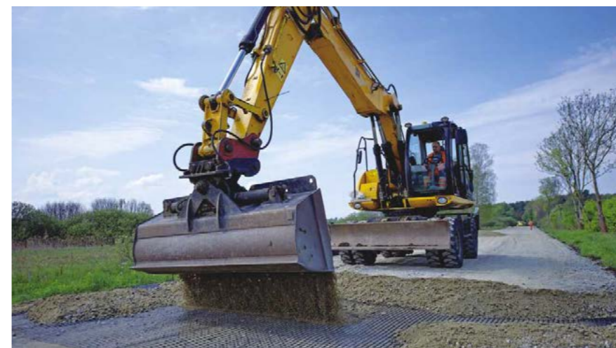
📍 Rzepin (woj. lubuskie) 📄 Materac geosyntetyczny na drodze wojewódzkiej 🧺 Polgrid BX 20/20 oraz Polgrid BX 45/45 25.000 m 2
