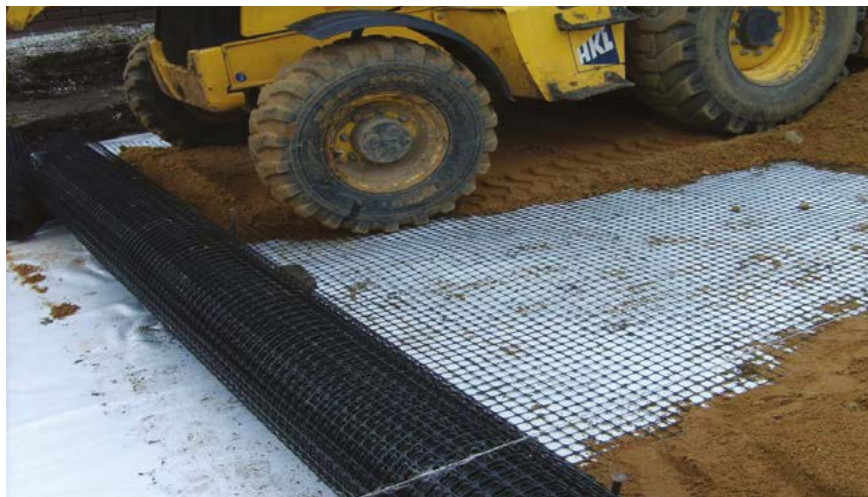
📍 Łódź (woj. łódzkie) 📄 Przebudowa ul. Styłowej 🔲 Polgrid BX 30/30 oraz geotkanina 10.000 m 2
