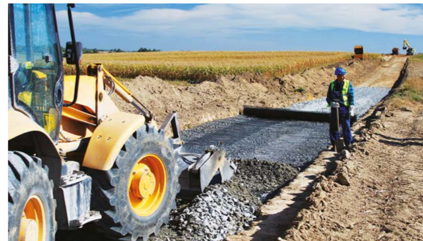
📍 Kunów (woj. świętokrzyskie) 📄 Budowa tymczasowej drogi technologicznej przy przebudowie linii kolejowej 🔲 Polgrid BX 30/30 oraz geotkanina separacyjna 7.000 m 2
