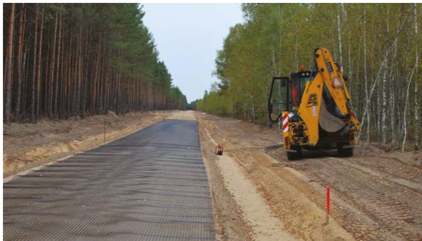
📍 Gubin (woj. lubuskie) 📄 Budowa drogi leśnej przeciwpożarowej 🧺 Polgrid 30/30 20.000 m 2
