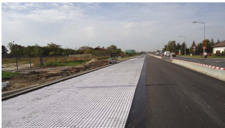
📍 Kalisz (woj. wielkopolskie) 📄 Przebudowa ul. Wrocławskiej, wzmocnienie warstw bitumicznych 🔲 Polgrid FSR BX 20/20 150PP 48.000 m 2
