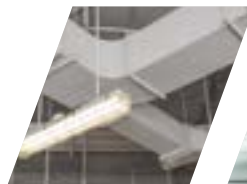
Kanały wentylacyjne i klimatyzacja
