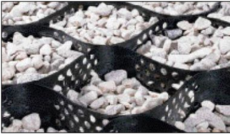
Rys. 8. Zасыpywanie kruszywem komórek geosiatki za pomocą ładowarki
