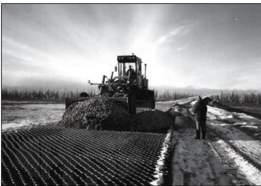
Rys. 8. Zасыpywanie kruszywem komórek geosiatki za pomocą ładowarki
